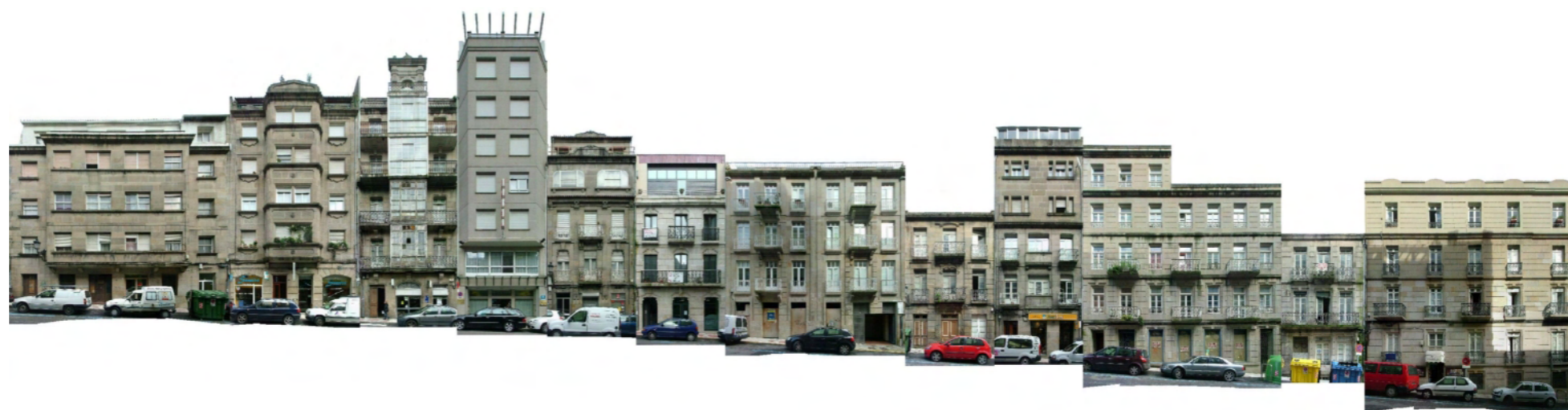
FACHADA RÚA PROGRESO
