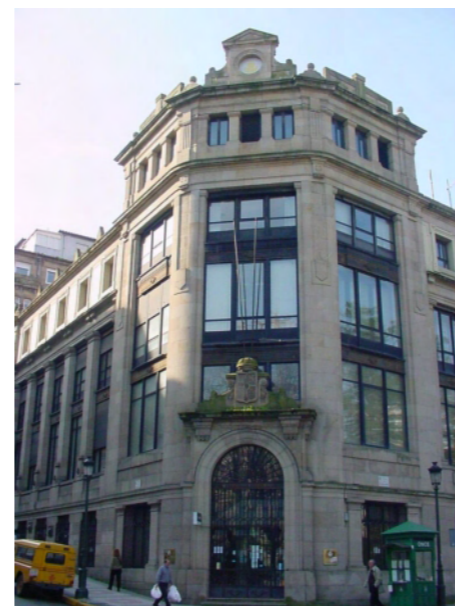
CORREOS E TELÉGRAFOS (1919-23). ARQ. M. GÓMEZ ROMÁN
