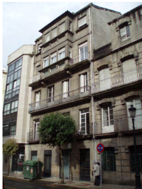
FACHADA RÚA PI Y MARGALL
