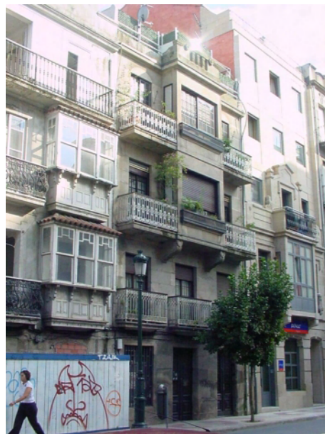
FACHADA RÚA PI Y MARGALL
