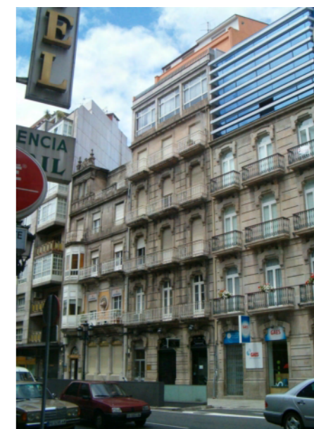
EDIFICIO ESQUINA LEPANTO URZAIZ
