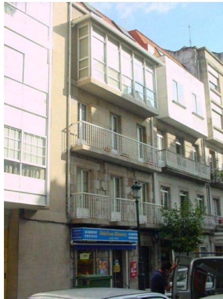
FACHADA RÚA PI Y MARGALL
