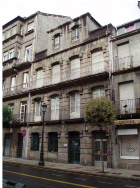
FACHADA RÚA PI Y MARGALL
