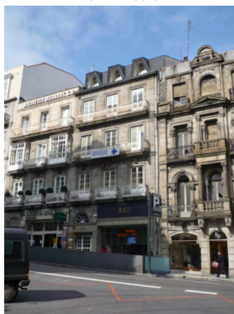
FACHADA A COLON
