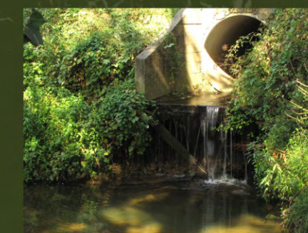
Vertido de augas depuradas
