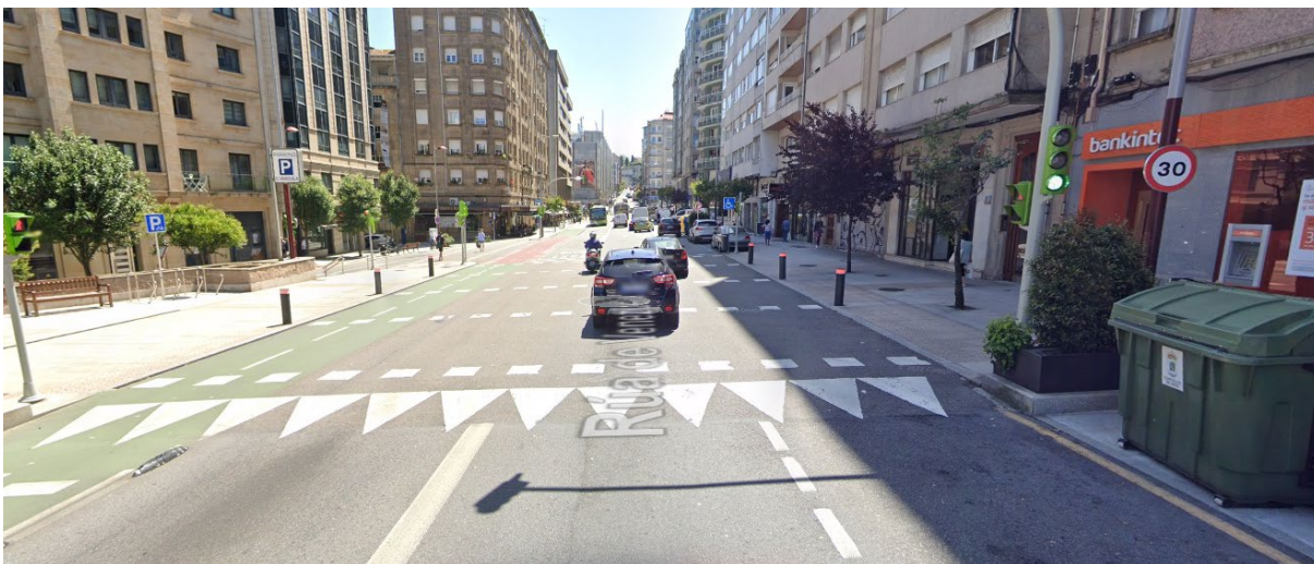
Figura 19. Humanización, asfaltado e carril bici en Rúa Venezuela, nas proximidades de Gran Vía
