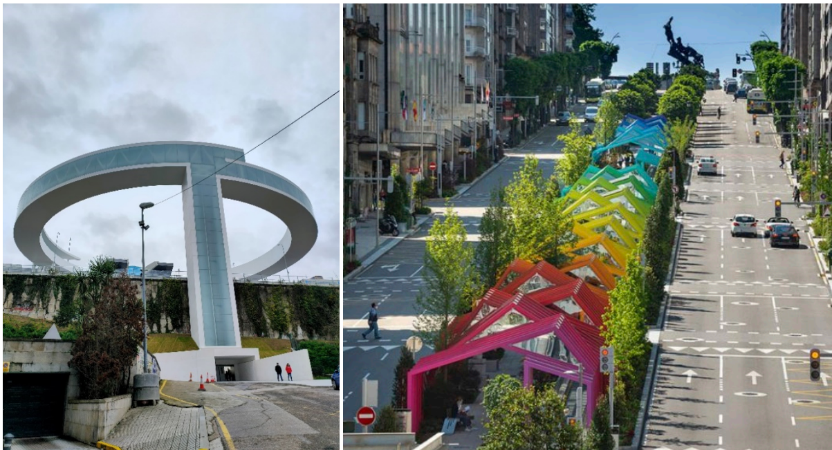
Figura 36. Vista dalgũa das obras levadas a cabo dentro do proxecto Vigo Vertical. Á esquerda, o ascensor HALO; á dereita, ramplas mecánicas da Avenida da Gran Vía
