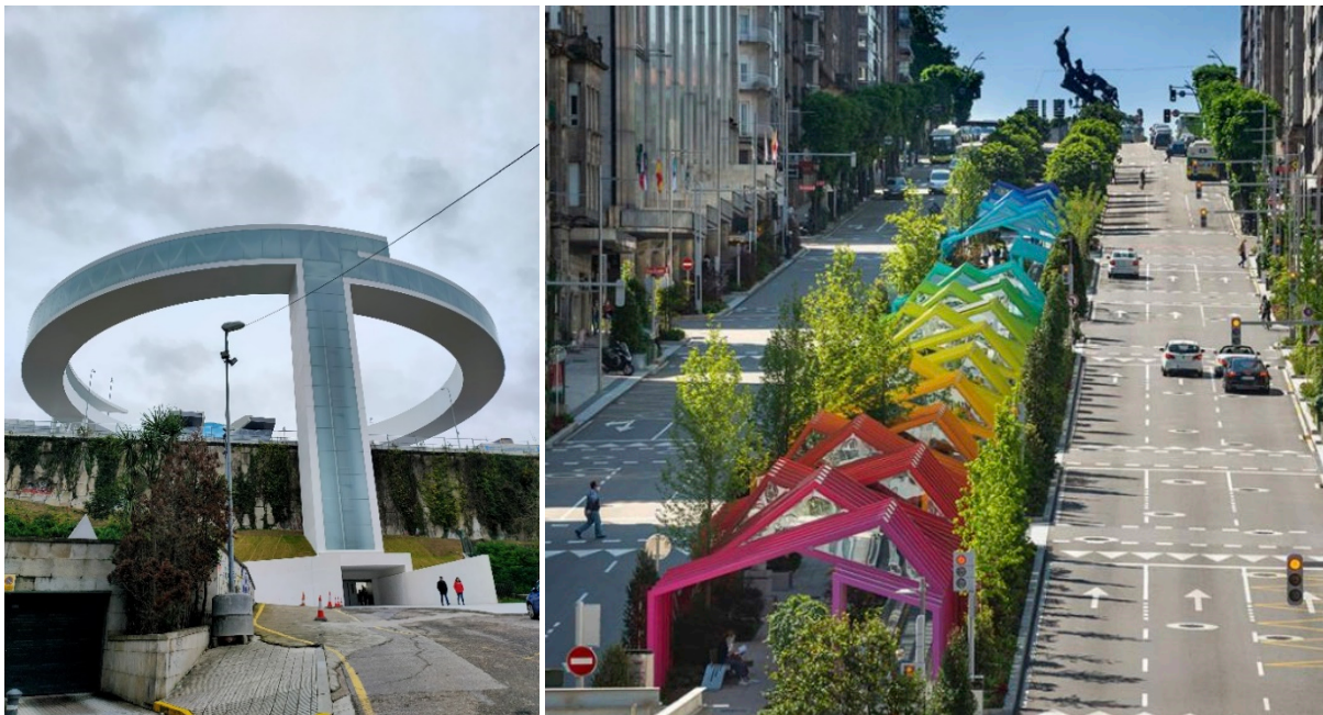
Figura 36. Vista de alguna de las obras llevadas a cabo dentro del proyecto Vigo Vertical. A la izquierda, el ascensor HALO; a la derecha, rampas mecánicas de la Avenida da Gran Vía
