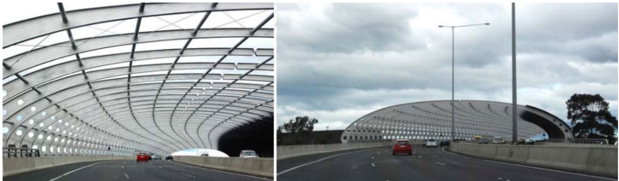
Figura 27. Ejemplo de apantallamiento tipo túnel para reducción de ruido
