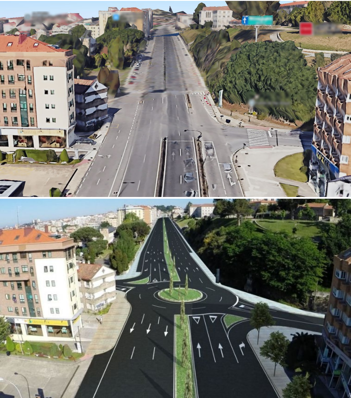
Figura 21. Estado actual de la Avenida de Madrid (arriba) e infografía publicada como ejemplo del resultado de las obras de humanización de la misma (abajo)
