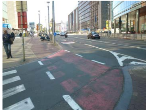
Ejemplo de badén en carril de giro, ante presencia de ciclistas
